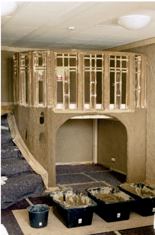
Ausfüllen des Holzskeletts mit Lehm.
