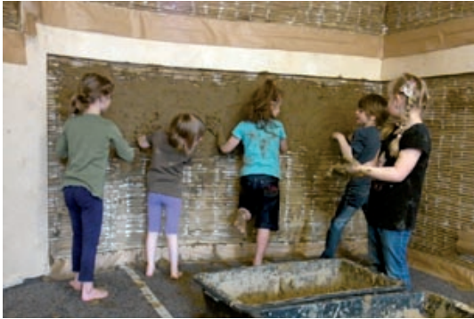
Aufbringen von Unterputz auf die Schilfmatte.
