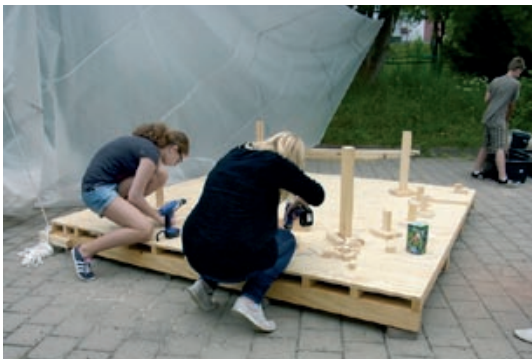
Montage des Holzständerwerkes.
