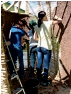
Lehmauftrag auf Schilfmatten.
